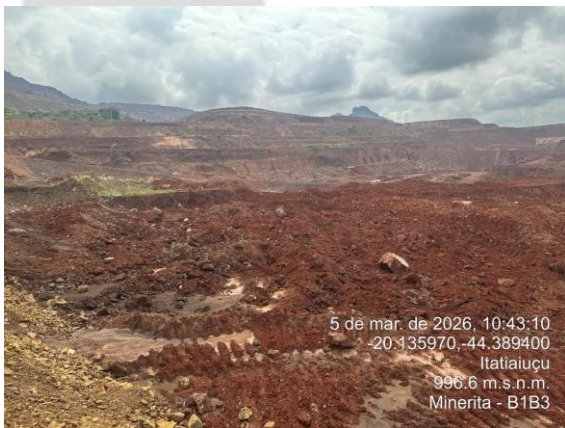
Foto 5: Área remanescente da área do antigo barramento e reservatório.
