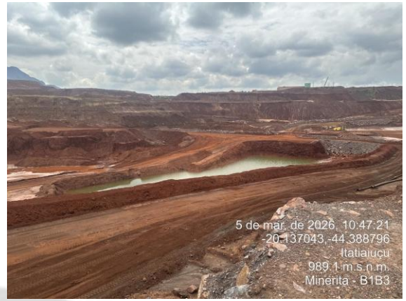
Foto 2: Sump construído em região escavada em terreno natural para drenagem da pilha, antiga região do reservatório.
